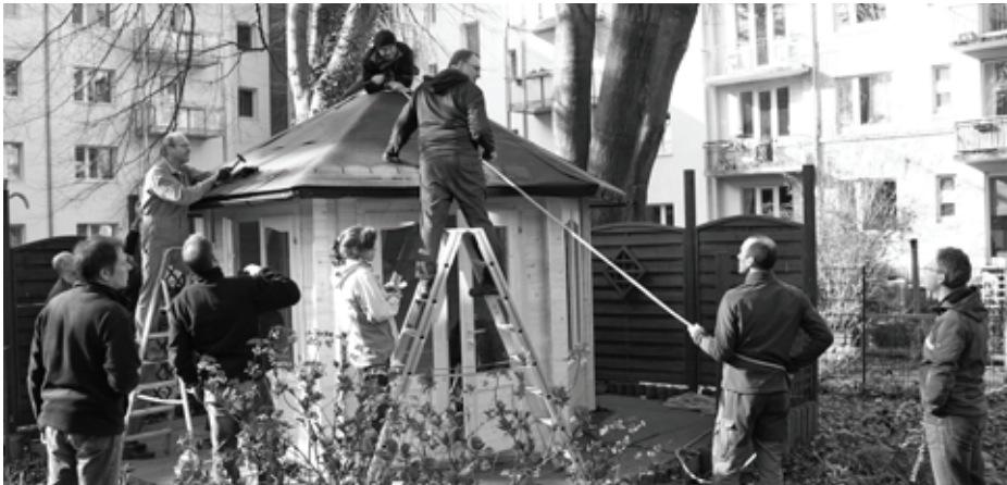
Ein 15-köpfiges Freiwilligenteam baute für das Wohnhaus Hufnerstraße des Rauhen Hauses einen Gartenpavillon auf.
